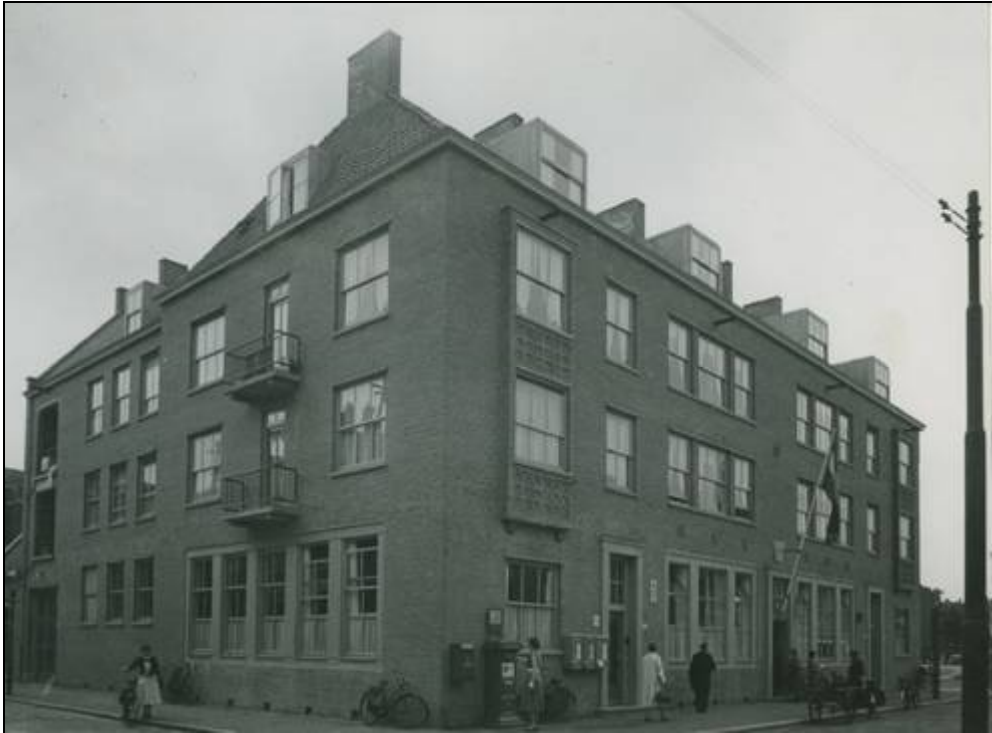
Bild 19: Großaufnahme der Postgebäude mit Briefkasten und Postautomaten.
