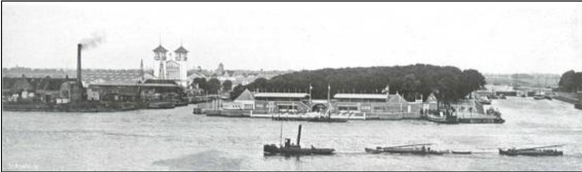
Bild 2: Das Ausstellungsgelände vom Bahnhof aus gesehen mit dem Landesteg für die Fähren
